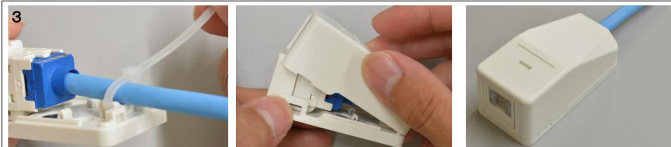
◆結束バンドでケーブルを固定し、カバーを取付けて完成です。
