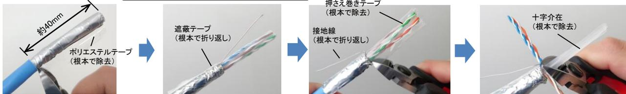
◆皮むき器で外被を約40mm除去し、ポリエステルテープを取り除きます。遮蔽テープと接地線を折り返し、押さえ巻きテープ、十字介在を外被根元で除去します。
