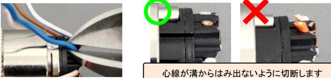
◆ニッパで余分な心線を切断します。溝端面に沿って切断してください。
