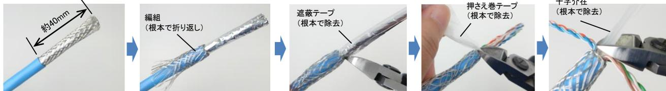
◆皮むき器で外被を約40mm除去し、編組を折り返します。遮蔽テープ、押さえ巻テープ、十字介在を外被根元で除去します。
